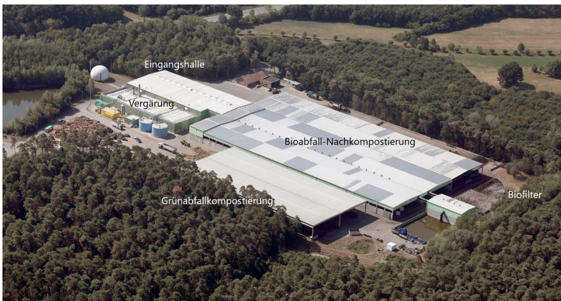
Abbildung 17: Luftaufnahme des Kompostwerks mit Vergärungsanlage
